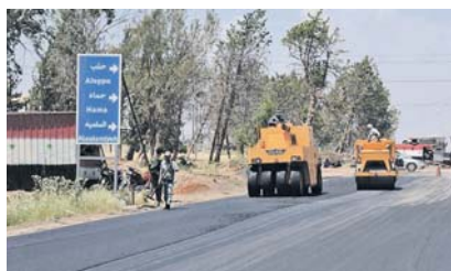
Идёт восстановление международной автомагистрали «М-5», на участке дороги Эр-Растан — Тель-Биса.
