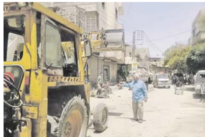
Восстановление разрушенных районов идёт полным ходом.
