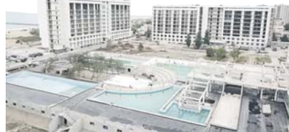
Завершается строительство ВИТ «Эра».
