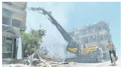
Идёт расчистка разрушенных кварталов.
