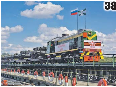
Эшелон с тяжёлой техникой на наплавном железнодорожном мосту.
