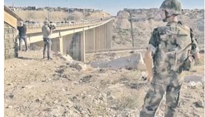
Восстановленный мост в Эр-Растане.
