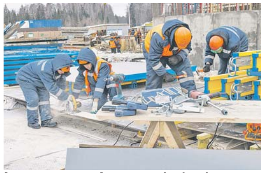
Строительство ведут специалисты Главного управления обустройства войск.
