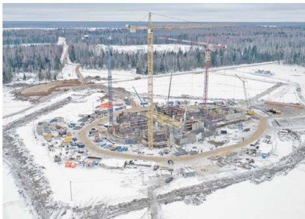
Работы идут полным ходом.
