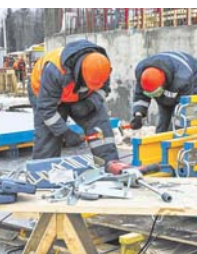
Идёт строительство Храма.
