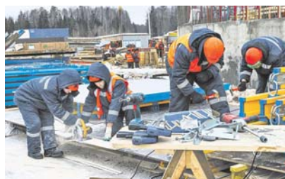
Идёт строительство Храма.
