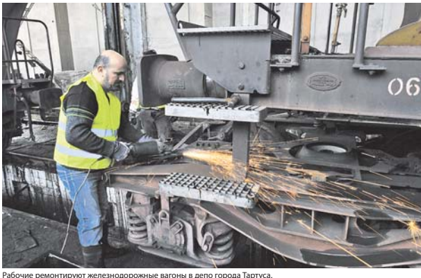
Рабочие ремонтируют железнодорожные вагоны в депо города Тартуса.
