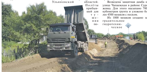
На реке Ия сооружаются дополнительные защитные дамбы.
