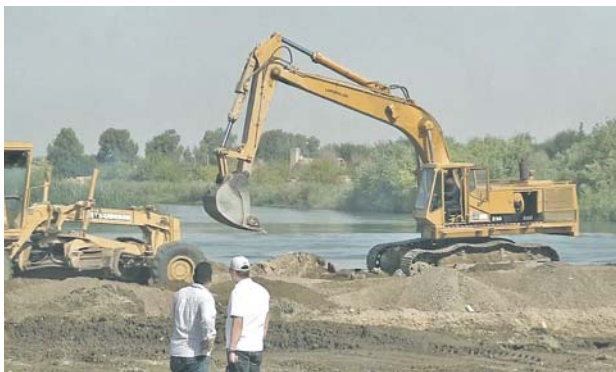
Идёт строительство моста через Евфрат.
