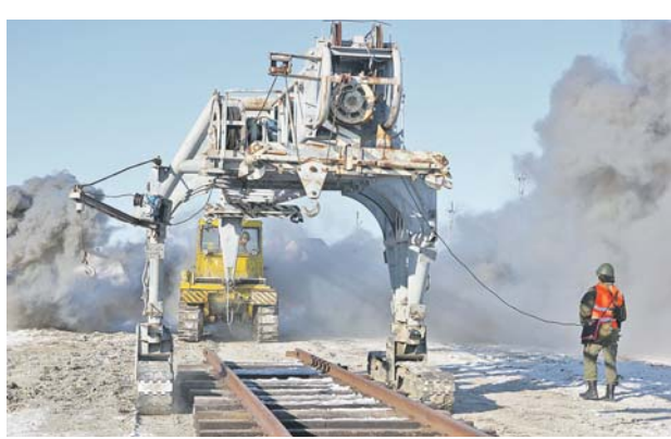
Главная задача Железнодорожных войск — строительство новых магистралей, повышение живучести и пропускной способности действующих.
