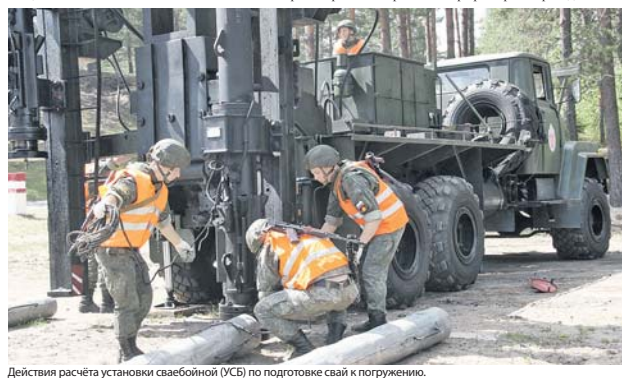
Действия расчёта установки свабейной (УСВ) по подготовке свай к погружению.
