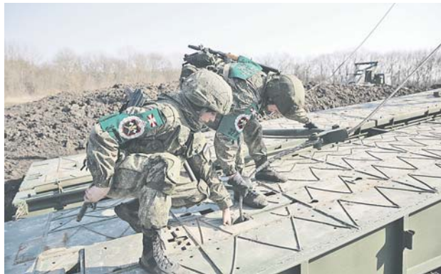
Инженеры ЮВО ждала серьезная проверка на прочность.
