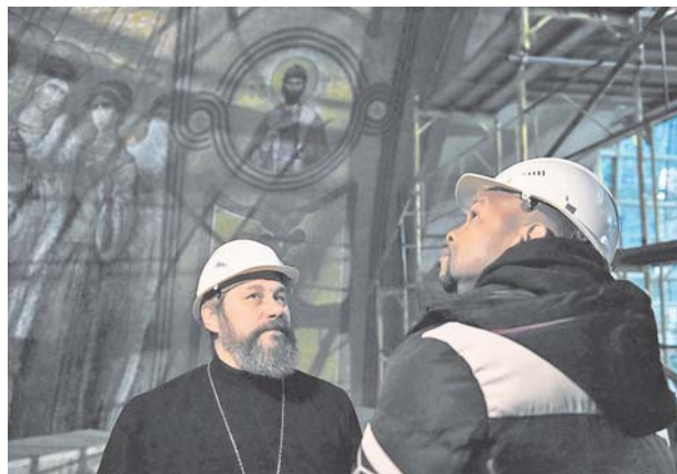
Рой ДЖОНС (справа) под сводами строящегося храма.
