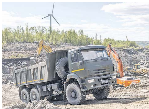
Отсыпка грунта продолжается.
