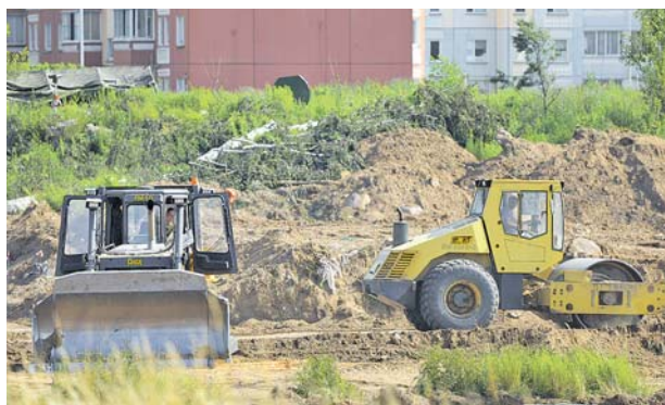
К работам привлечены 30 единиц специальной военной техники железнодорожного соединения ЗВО.
