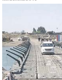
Российские инженеры уже не в первый раз помогают жителям провинции Дейр-эз-Зор. На фотографии — мост, сооружённый весной этого года.
