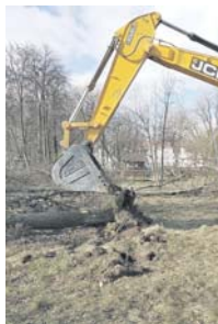
Строительство многофункционального госпиталя в городе Подольске.
