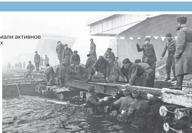
Советские сапёры наводят понтонную переправу через реку Одер, апрель 1945 г. Фото Аркадия ШАЙХЕТА.
