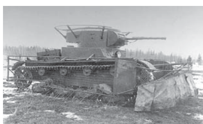
Испытание танка Т-26 в защитном обвесе. Научно-испытательный автобронетанковый полигон АБТУ РККА. 1935 год.
